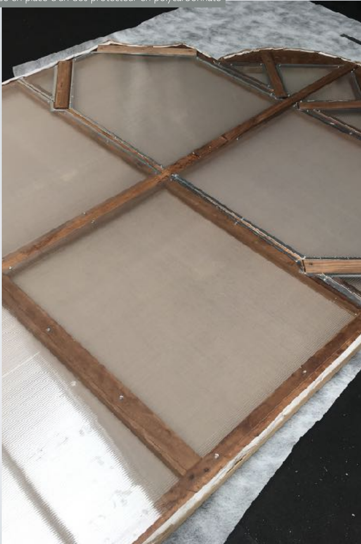
Mise en place d'un dos protecteur en polycarbonnate
