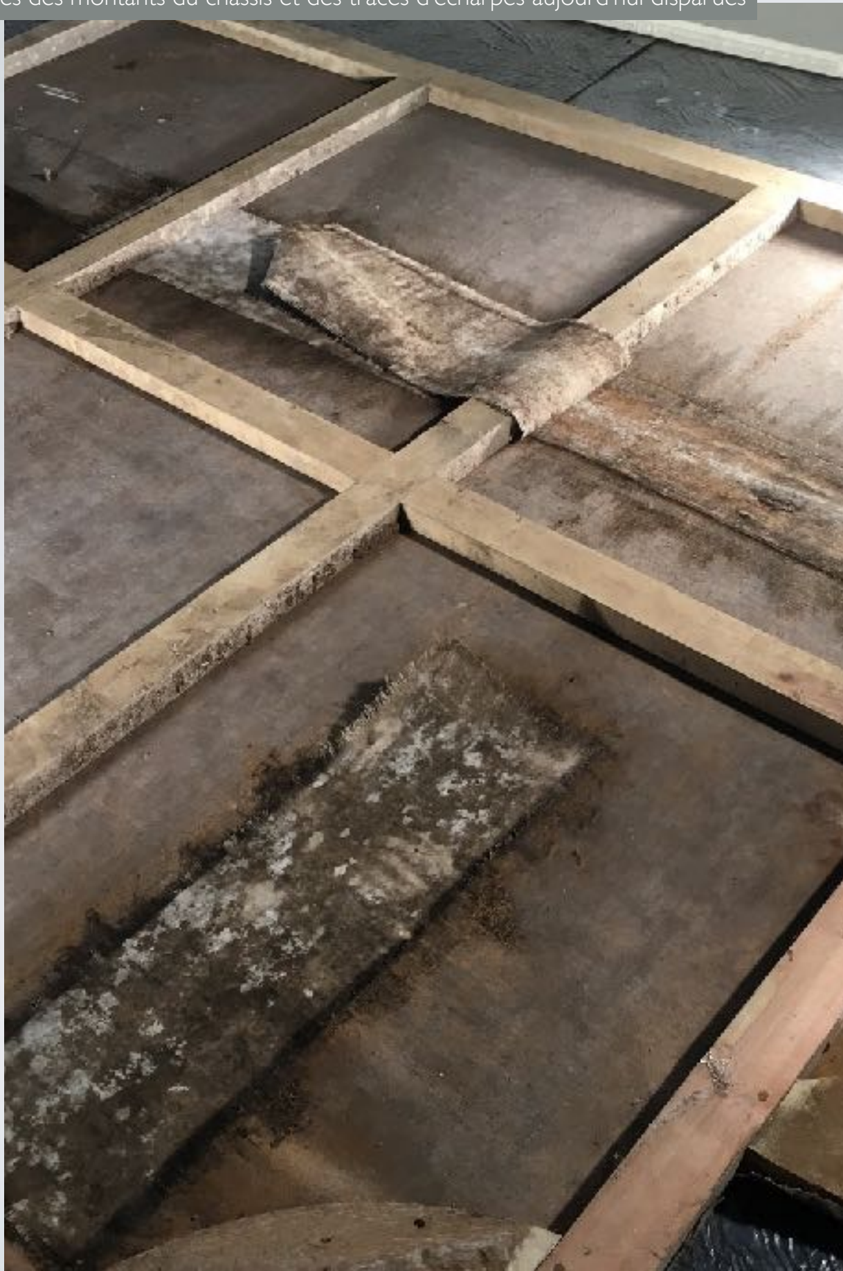
Vues des montants du châssis et des traces d'écharpes aujourd'hui disparues
